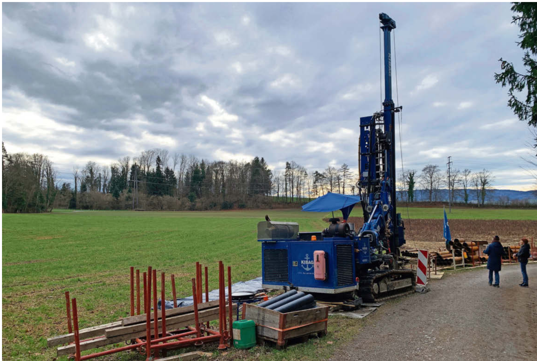
Für eine neue Linienführung im Aatal wurde auch der Untergrund im Gebiet Holberg bei Oberuster untersucht. Foto: Christian Brändli
